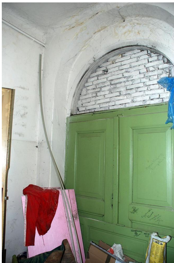
818. Přízemí (1.N.P.), místnost č. OP31, západní stěna se zazděným vstupem.
